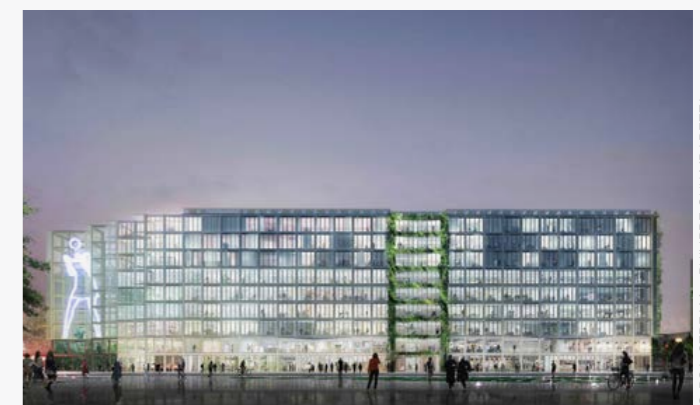
VUE DU STREAM-BUILDING, PORTE DE CLICHY.
