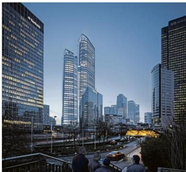
The Link consiste en deux tours siamoises de 50 et 35 étages au-dessus du parvis de La Défense, reliées sur trente niveaux par des passerelles vitrées (les « links »). Photo The Link ArteFactory pour PCA-Stream.
