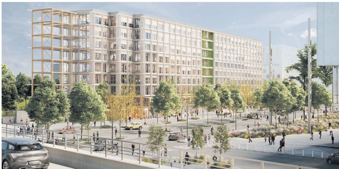
L'édifice de 120 mètres de long, aux façades en bois, se termine par une exostructure ouverte qui abritera une œuvre d'art face au périphérique. PCA-STREAM
